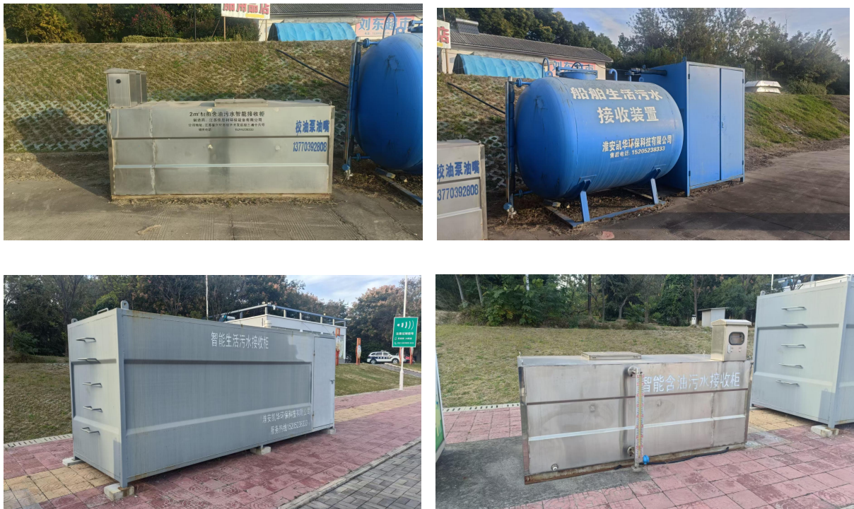
图 3.2-9 杨庄船闸现状船舶废水接收装置
