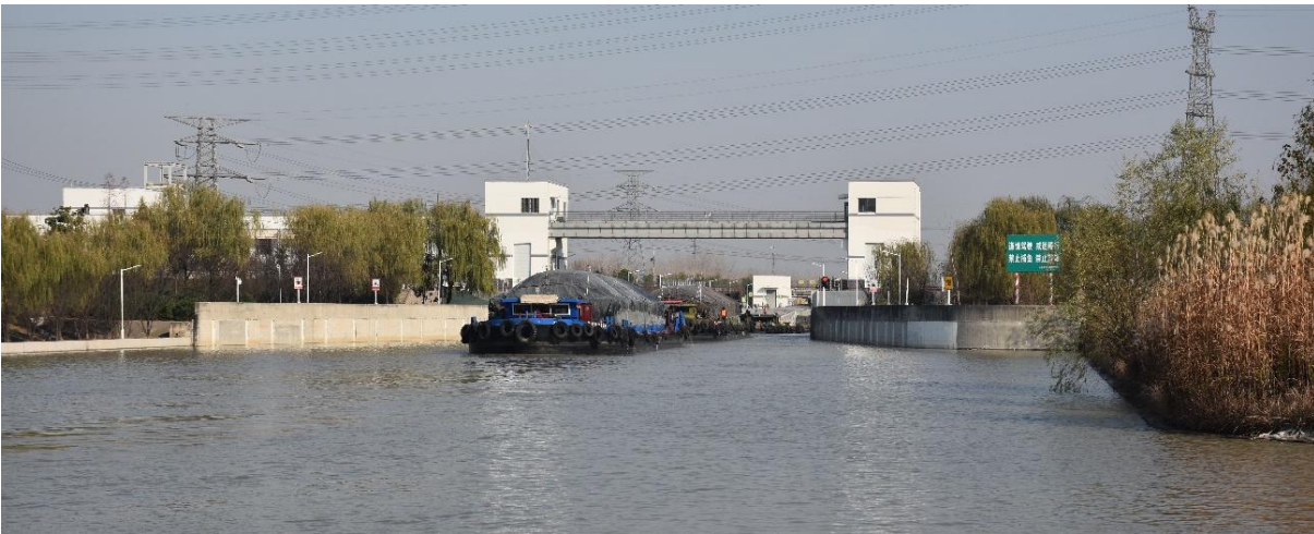
图 3.2-4 杨庄二线船闸闸室图
