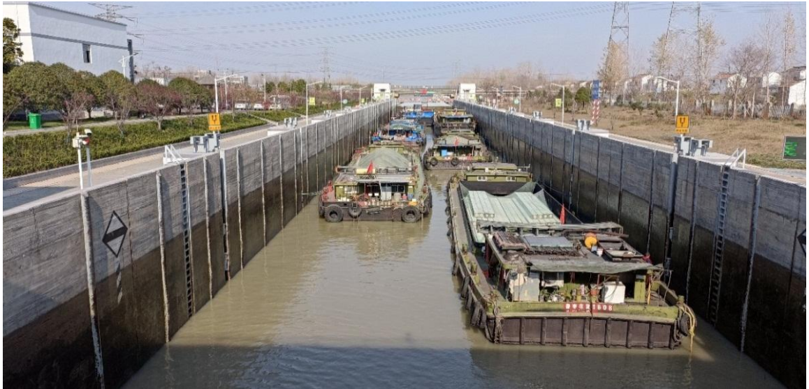
图 3.2-5 杨庄二线船闸闸室图
