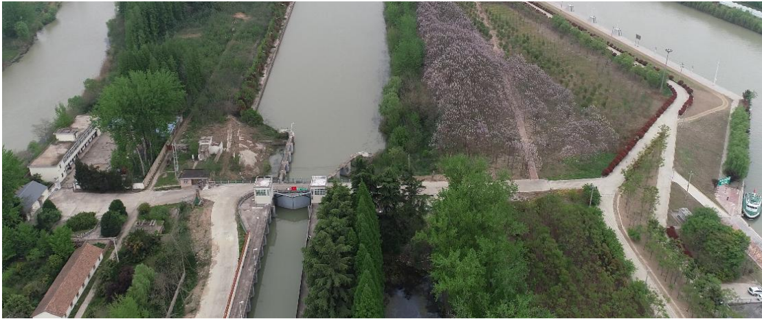
图3.2-7 现状杨庄一线船闸桥
