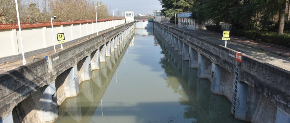
图 3.2-3 杨庄一线船闸闸室图
